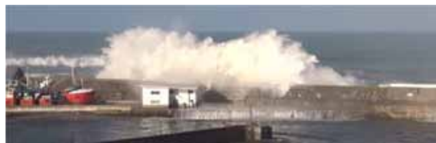
Figura 2. Rebase sobre el tramo 1 del dique de abrigo. Fuente: Gobierno Vasco (2014).
