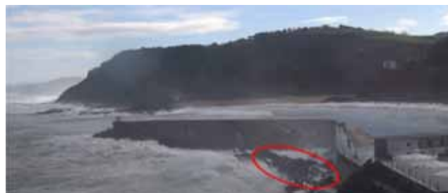
Figura 3. Efecto de los bajos rocosos en el rebase. Fuente: TYPESA (2021).
